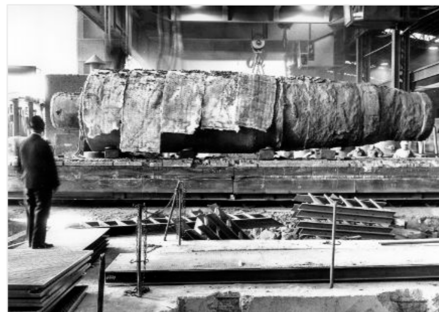
Schwerstwalze mit noch als Stummel ausgeführten oberen Zapfen.
