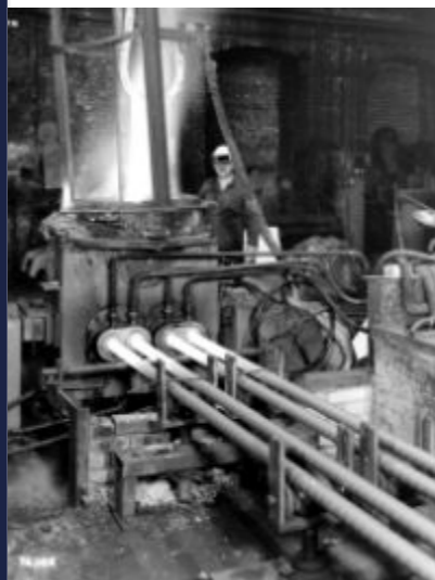
Blockkopfheizung Strangguss in den 1970er Jahren
