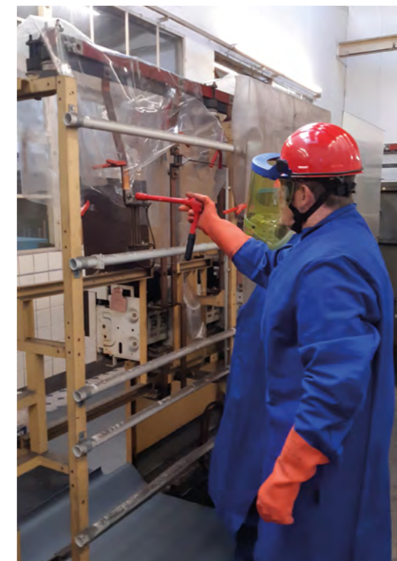
Arbeiten mit Spezialwerkzeug (Isolierung bis 1000V)
