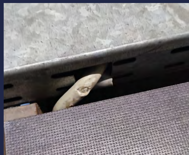
Defektes Kabel
