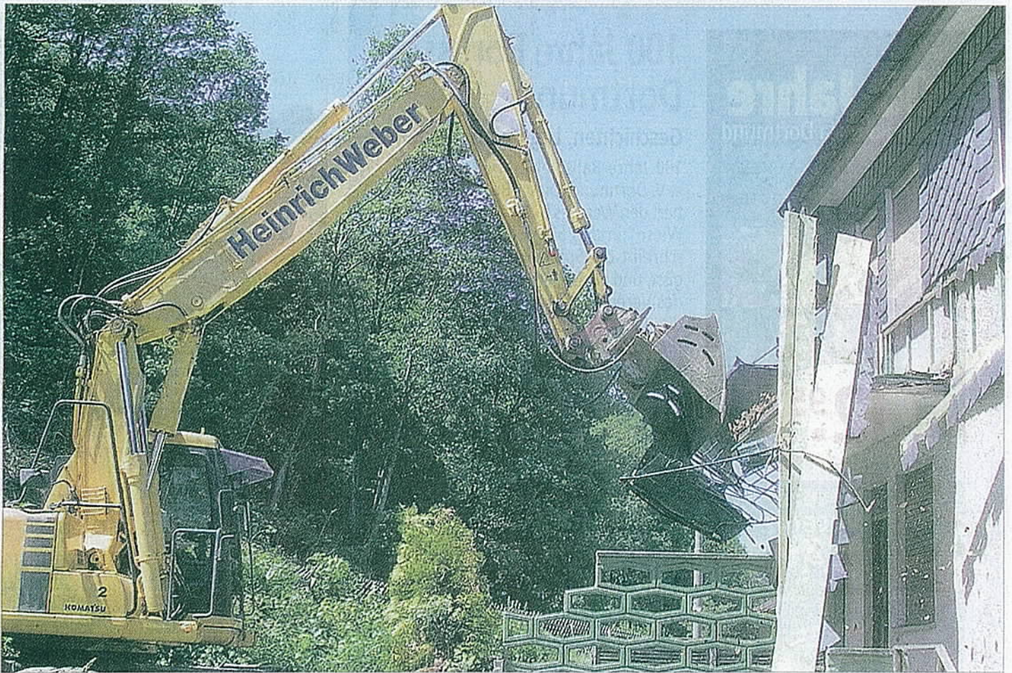
Mit dem offiziellen Beginn des Ausbaus des Kichtaler Wegs in Kaan-Marienborn musste dieses Haus im Bereich vor der Irle-Brauerei dem Abrissbagger weichen. Die mächtige Schaufel bediente Bürgermeister Steffen Mues. Foto:kk
